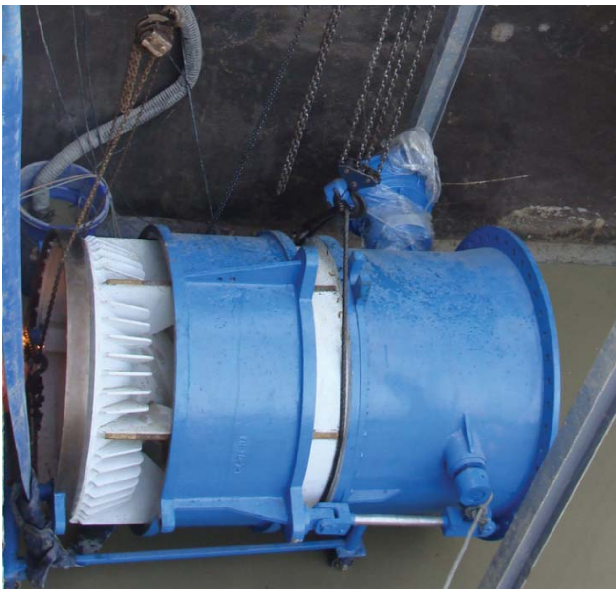
我厂DN1600固定锥形阀的安装现场
